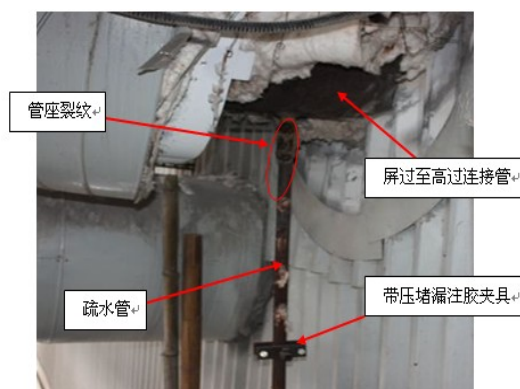
图 2 #5 炉 B 侧屏过至高过连接管疏水管座裂纹
