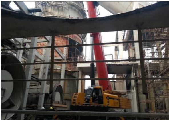
图 5 合金段被 220t 吊机成功吊出
