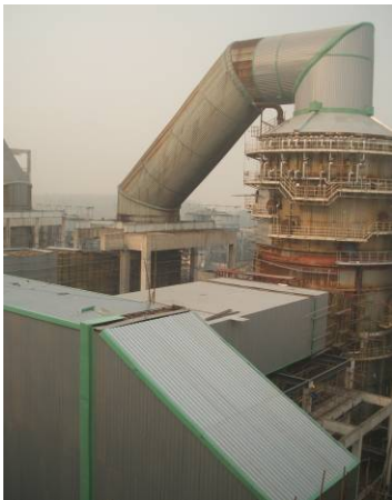
图 7 #5 炉烟道取直改造后全景图
