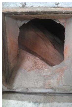
图3 左侧人孔门处积灰情况
