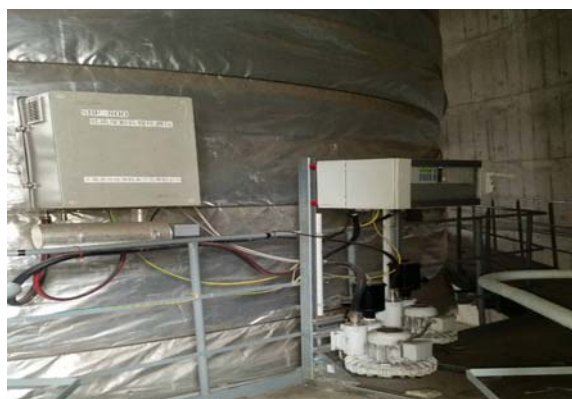
图6 某超低排放烟尘仪现场安装图
