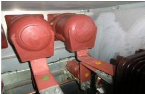
图 7 支排折弯处对触头盒出线口挡板放电
