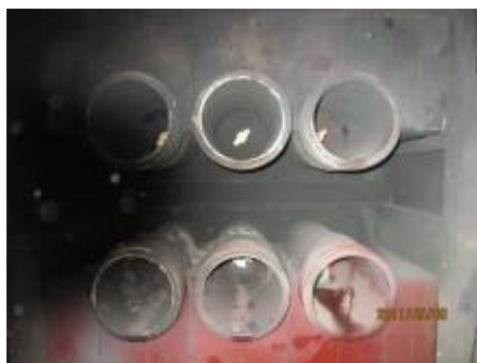
图 4 绍兴某变电站 40.5kV 开关柜相间短路爆炸图
