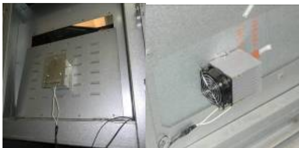
图 15 改造后母线可带电更换式的风扇加热器图
