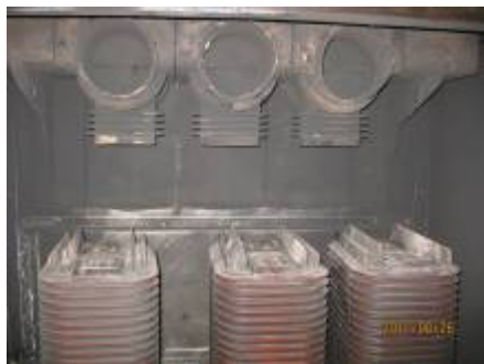
图 3 40.5kV 开关柜电缆室爆炸图
