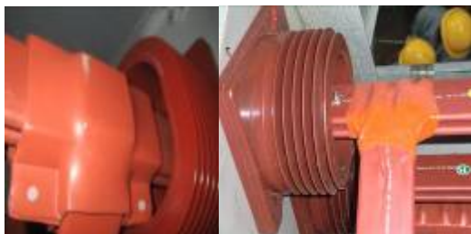
图 13 改造前及改造后搭接处包封效果图
