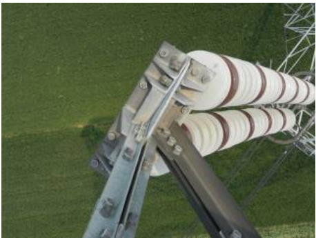
图 2 某 500kV 小转角塔边相横担
