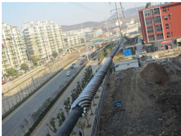
图 3 修补后的导线
