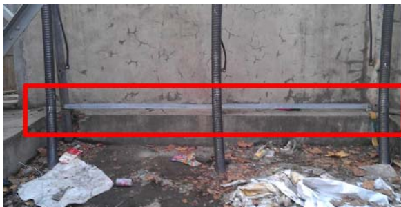
图 10：处理后的#1 塔电缆终端接地系统
