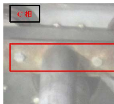
图 2 C 相终端构架撑杆螺栓
