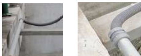
电缆沿水池边沿敷设并穿管 电缆管防水接头
