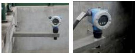
图 5 安装超声波水位计
