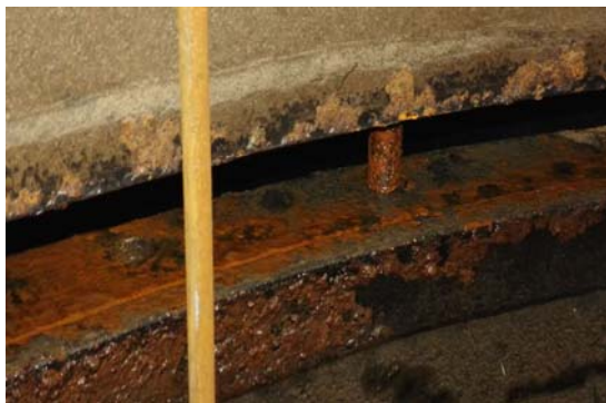
图4 B 筒体与出水弯管法兰张口
