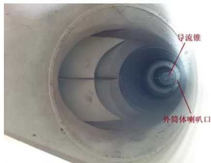
图 10 外筒体一侧落在进水导流锥上
