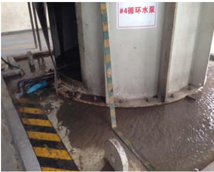
图 1 #4 循泵小端盖漏水情况
