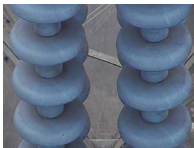
图3 大跨越南塔绝缘子积污情况
