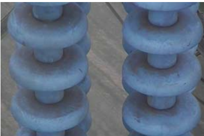
图 2 大跨越北塔绝缘子积污情况
