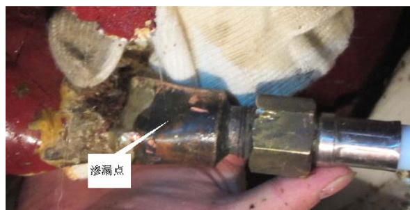
图 1 #4 机第 33 槽定子绕组绝缘引水管三通接头渗漏点
