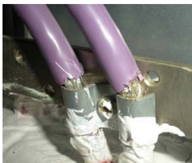
图 8 屏蔽层连接
