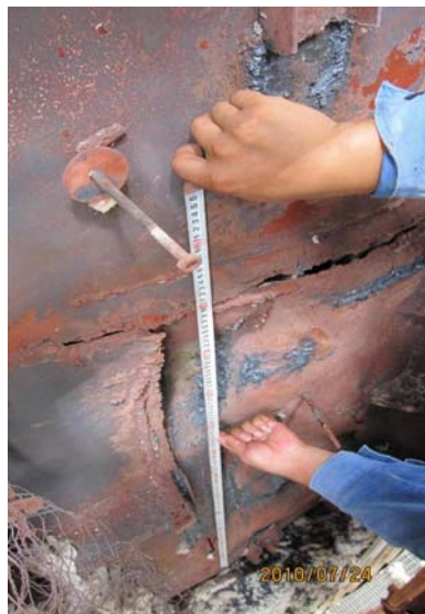
图2 墙体开裂上、下1000mm
