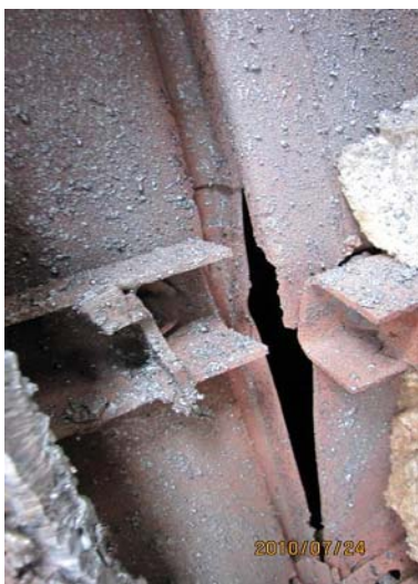
图5 内衬板变形和开裂
