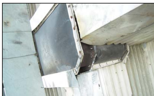
图7 锅炉转角烟道蒙皮密封图
