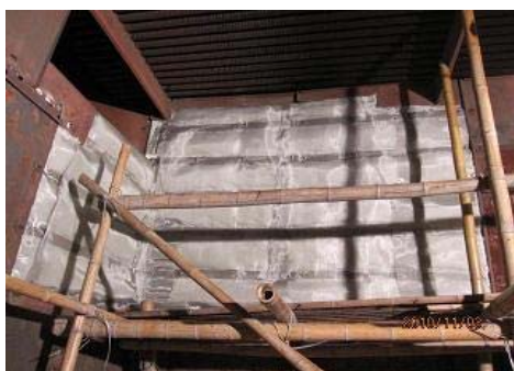
图15 保温和不锈钢丝网施工
