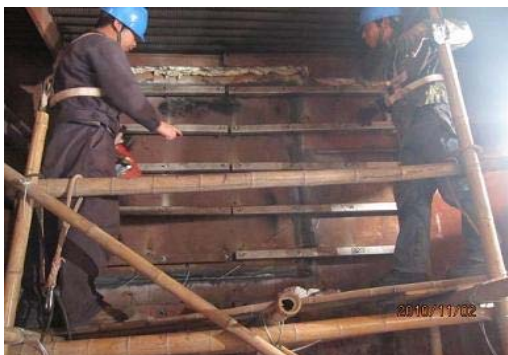
图14 焊接压条螺栓和压板
