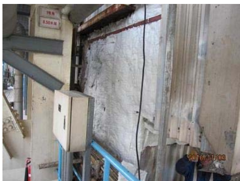
图17 外保温施工
