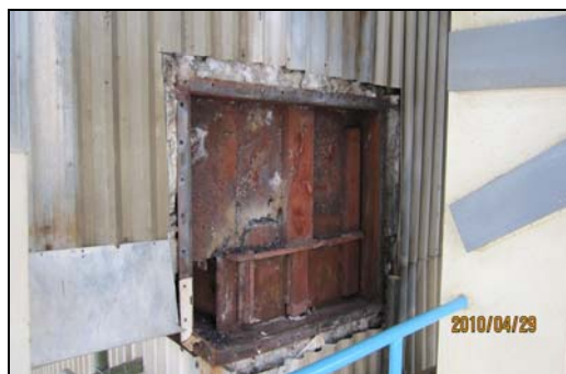
图6 锅炉转角烟道密封框架图
