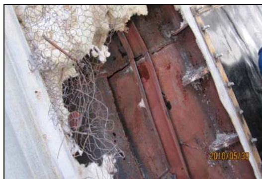
图8 密封框架外再次开裂
