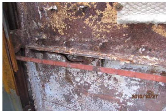
图9 密封框架外再次开裂
