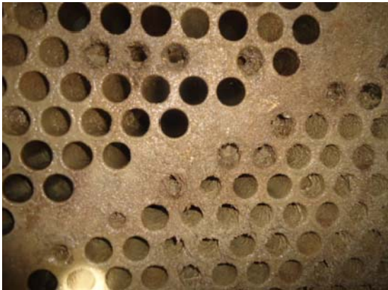
图1 凝汽器不锈钢管内部情况
