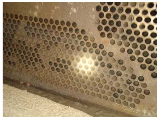
图 13 2014 年 7 月 17 日#1 机组调停时凝器钢管照片（未改造）
