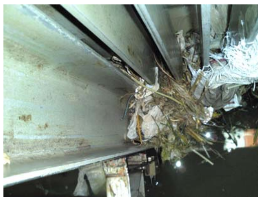
图 4 拦污栅耙斗导轨杂物堵塞
