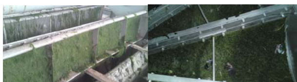
a) 旋转滤网网面 b) 二次滤网网面
