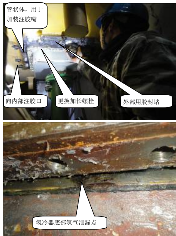
图2 “内部螺栓孔注胶，外部强力胶堵缝”堵漏方法
