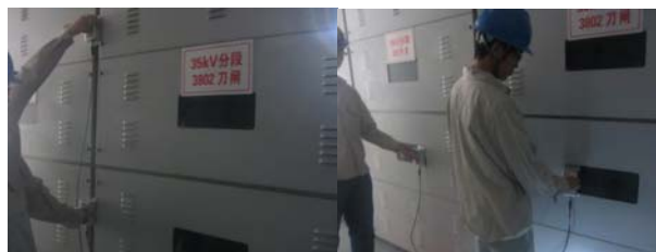
图 6 “35kV 分段 3802 刀闸” 放电信号定位照片
