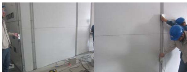
图 15 “35kV0 号所用变 311 开关” 电晕信号定位照片
