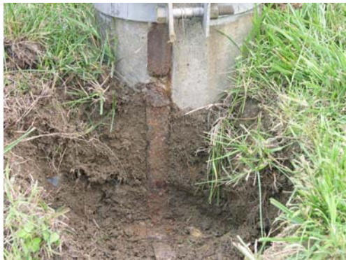
图 3 接地引下线的腐蚀
