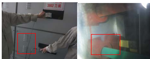
图 8 “35kV 分段 3802 刀闸” 放电信号源位置
