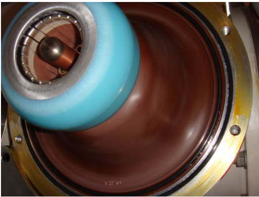
图 2 处理后的盆式绝缘子
