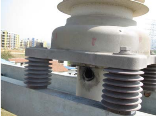
图 1：电缆终端击穿故障
