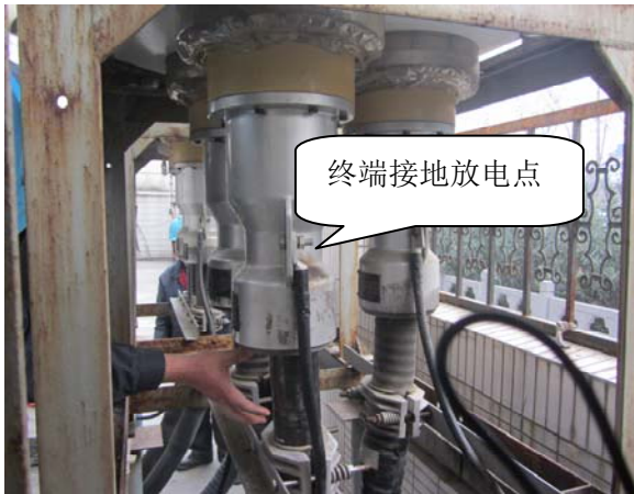
图 6 电缆终端放电痕迹
