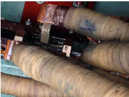
图 1 变压器内部出现的大量铜质微粒
