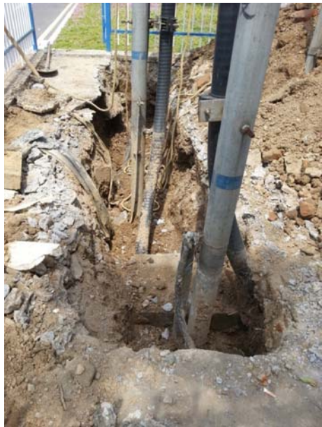
图 5：开挖后终端站柱无基础
