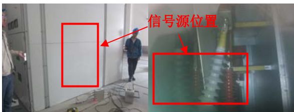
图 18 “35kV0 号所用变 311 开关” 电晕信号源位置
