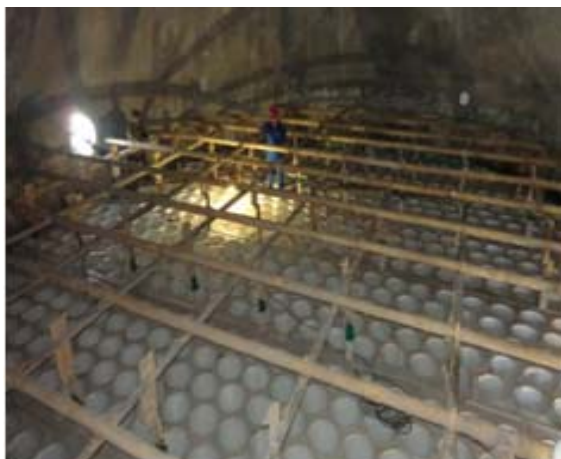
图 7 管束式除尘除雾器的现场安装实例
