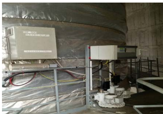
图6 某超低排放烟尘仪现场安装图
