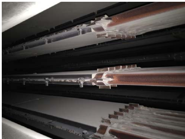
图 1 低温再热器包裹后俯视图
