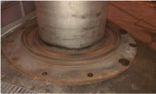
图8 分离器落煤管及法兰
