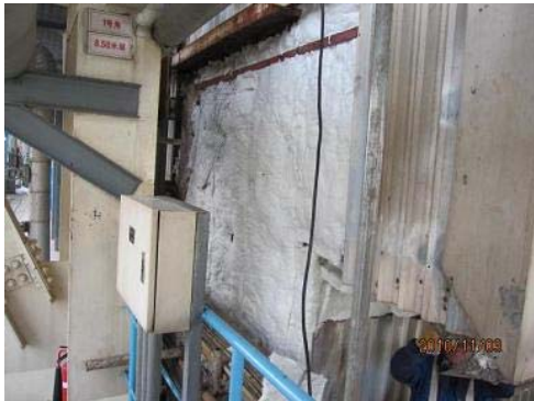
图17 外保温施工
