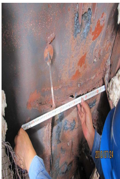
图3 墙体左、右开裂600mm
