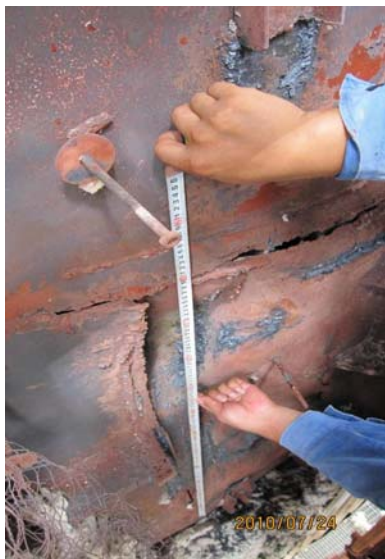
图2 墙体开裂上、下1000mm
