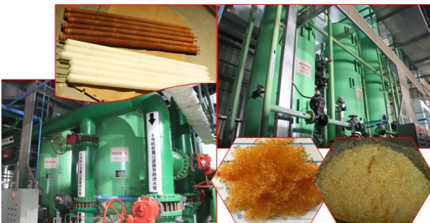
图 3 凝结水精处理系统更换滤芯及添加树脂
